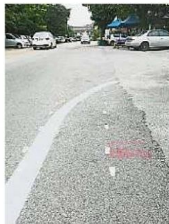
承包商已完成标记工作，接下来则会展开挖掘及安装工程。
